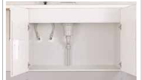
開き扉配管スペースなし
